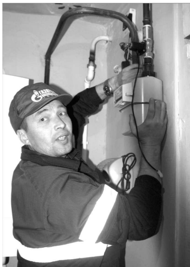
Слесарь по эксплуатации и ремонту газового оборудования Денис Гунчев тщательно проверяет установку перед запуском
